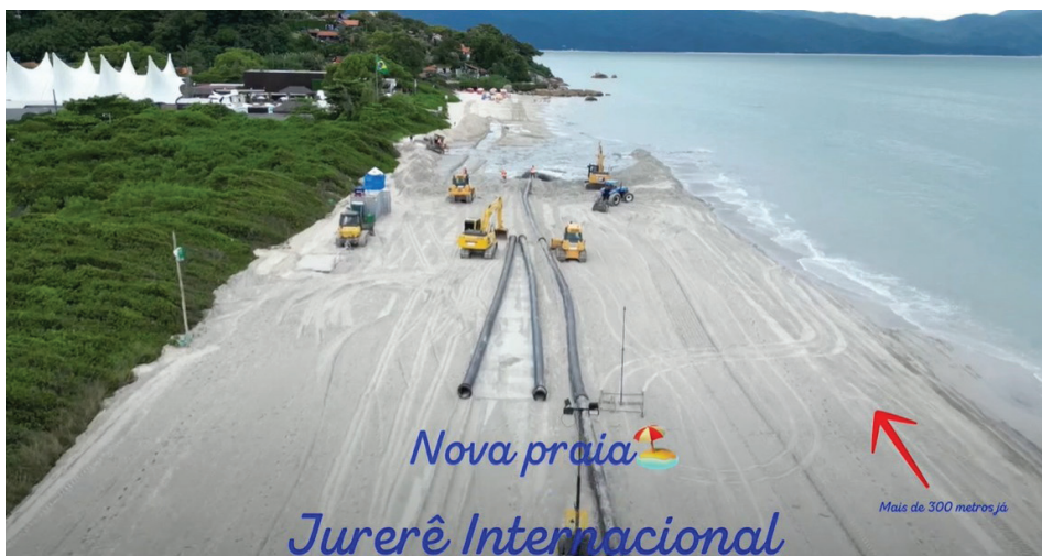
Figura 13 – Captura imagem em vídeo que evidencia a patrulha de equipamentos em operação no espalhamento de material na faixa de areia da Praia de Jurerê, em 2024 13
