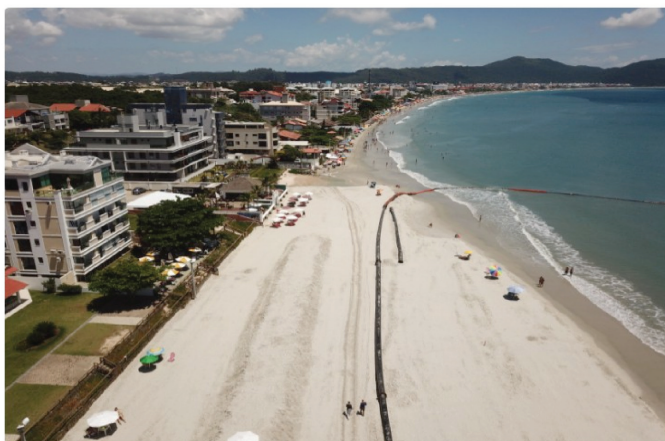
Figura 20 – Imagem aérea da execução da alimentação artificial da Praia dos Ingleses 16
